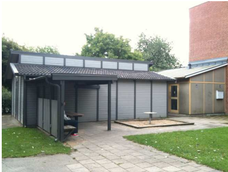
Figur 8 Tillbyggda förråd och tvättstugor mellan husens kortsidor
