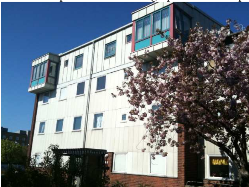
Figur 18 Påbyggnad från entrésidan
