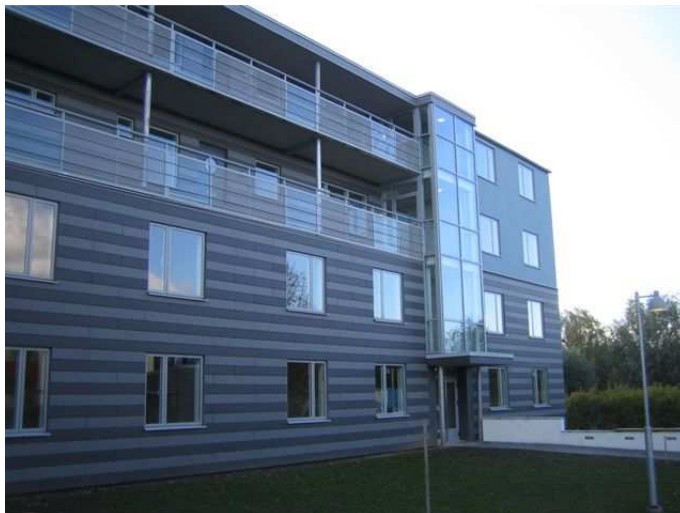
Figur 21 Norra Fäladen i Lund. Två extra våningar på två befintliga våningar
