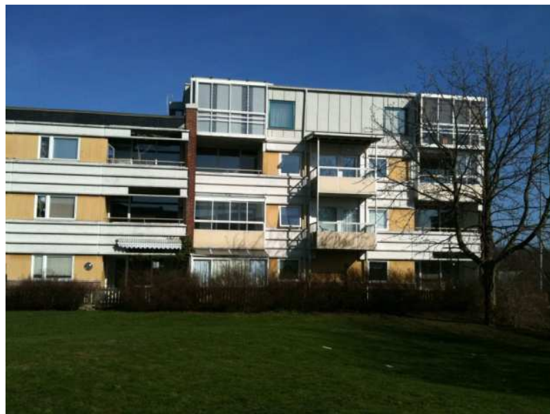
Figur 20 Påbyggnaden från baksidan där de extra balkongerna syns
